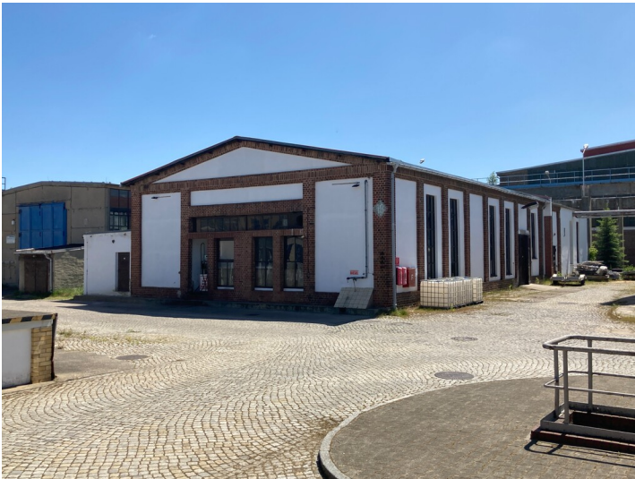
Blick auf die nordwestliche Gebäudeecke des westlichen Flügels Fotograf/Urheber: Josephine Dreßler
