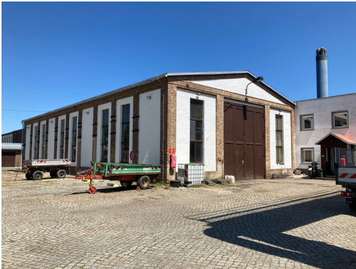
Blick auf die südwestliche Gebäudeecke Fotograf/Urheber: Josephine Dreßler
