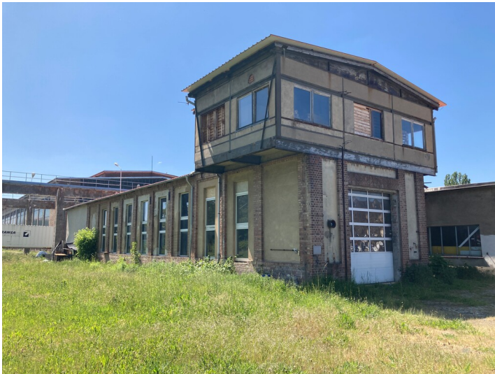
Blick auf die nordöstliche Gebäudeecke Fotograf/Urheber: Isabell Schmock-Wieczorek
