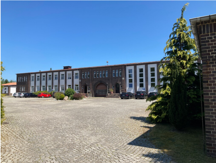
Blick auf die westliche Gebäudeseite (Verwaltung links, Waschkaue rechts des mittigen Eingangsbereichs) Fotograf/Urheber: Isabell Schmock-Wieczorek
