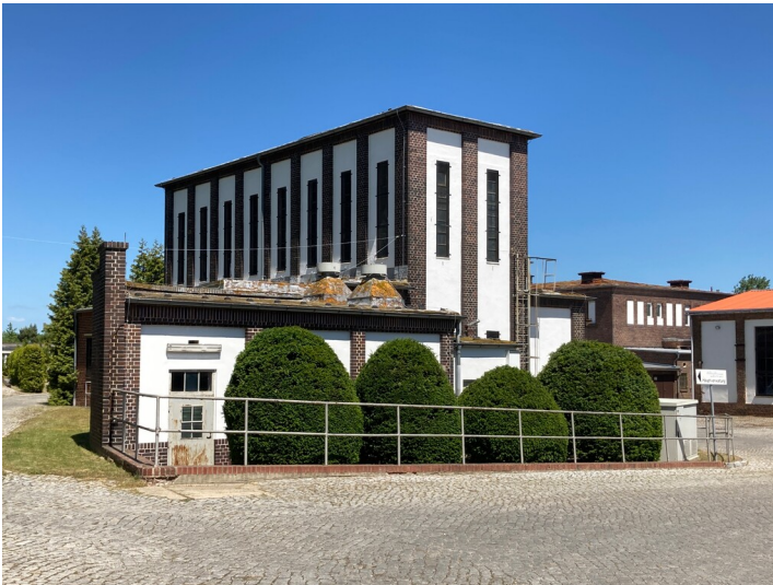
Blick aus südwestlicher Richtung Fotograf/Urheber: Josephine Drefßler
