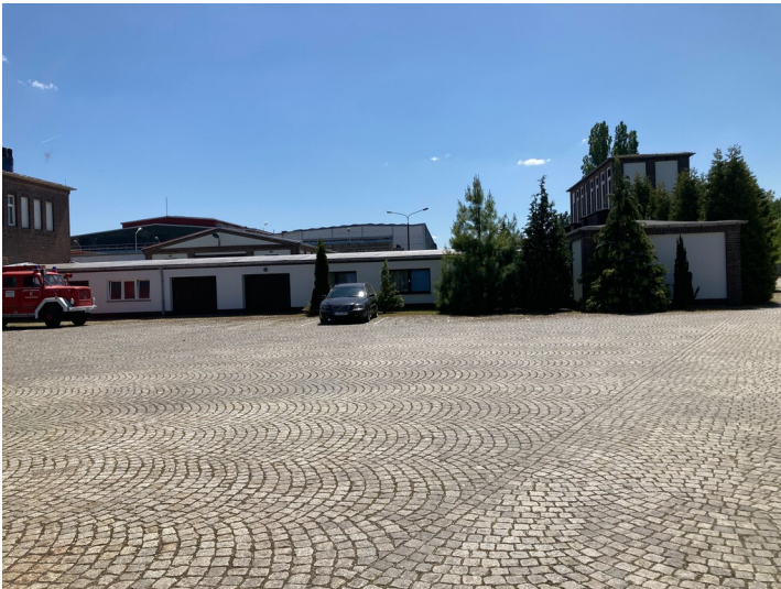
Blick auf die nördliche Traufseite Fotograf/Urheber: Isabell Schmock-Wieczorek
