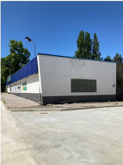
Blick auf die südöstliche Gebäudeecke Fotograf/Urheber: Isabell Schmock-Wieczorek
