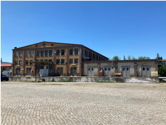
Blick auf die östliche Giebelseite Fotograf/Urheber: Josephine Drefßler
