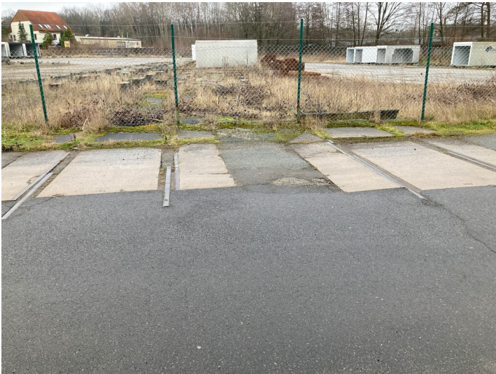
Gleisreste im Bereich der Brandiser Tonwerke/Waldbadweg, Blick Richtung Ost Fotograf/Urheber: Isabell Schmock-Wieczorek
