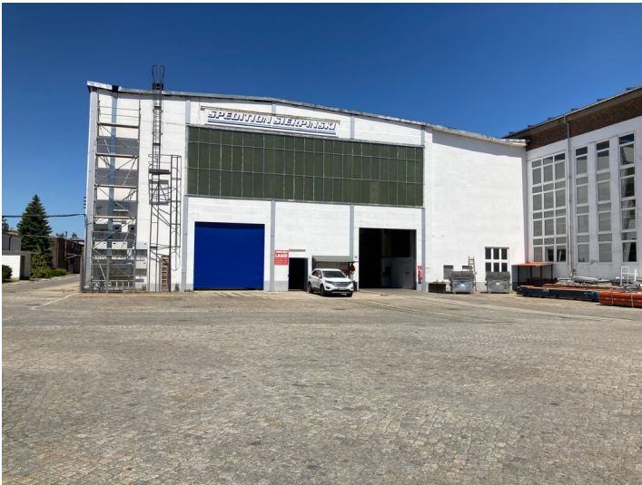
Blick auf die südliche Giebelseite Fotograf/Urheber: Josephine Drefler
