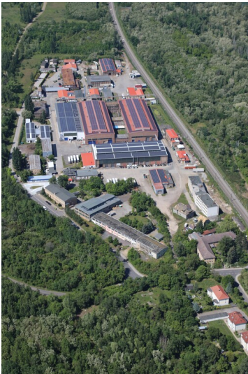
gesamtes Areal der ehemaligen Zentralwerkstatt, Luftaufnahme aus südlicher Richtung Fotograf/Urheber: Ronald Heynowski
