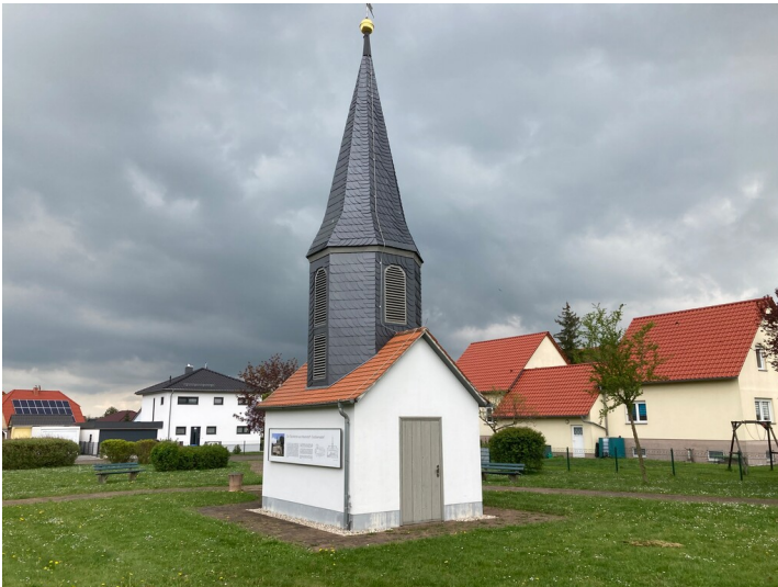
Blick aus westlicher Richtung Fotograf/Urheber: Christian Schmidt
