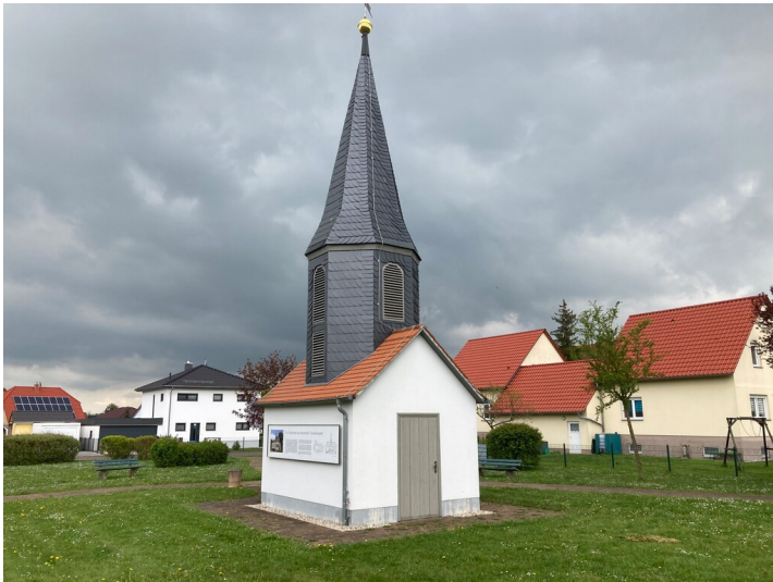
Blick aus westlicher Richtung Fotograf/Urheber: Christian Schmidt
