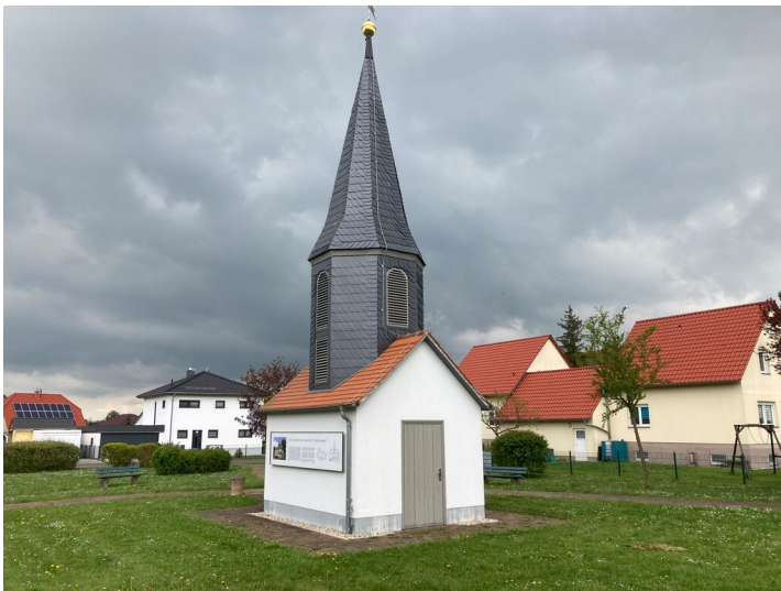
Blick aus westlicher Richtung Fotograf/Urheber: Christian Schmidt
