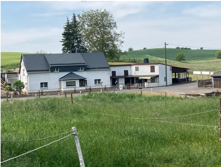
Wohnhaus und Verwaltungsgebäude aus östlicher Richtung Fotograf/Urheber: Isabell Schmock-Wieczorek
