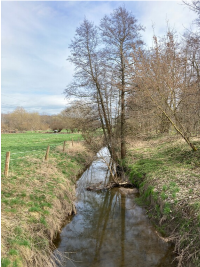
verlegte Eula nördlich des Speicherbecken Witznitz Fotograf/Urheber: Vincent Haburaj
