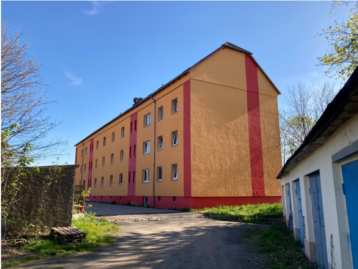
Mehrfamilienhaus aus nördöstlicher Richtung Fotograf/Urheber: Isabell Schmock-Wieczorek
