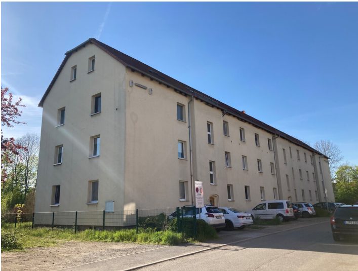
Aktivistenhaus aus südlicher Richtung Fotograf/Urheber: Isabell Schmock-Wieczorek
