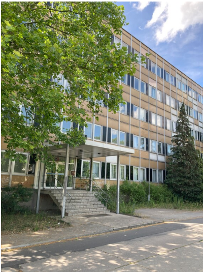
Eingang am südlichen Ende der östlichen Gebäudeseite Fotograf/Urheber: Nils Schinker
