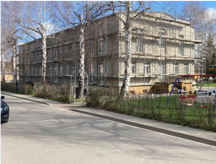
Bürogebäude aus südlicher Richtung Fotograf/Urheber: Christian Schmidt
