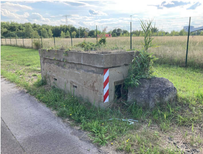
Splitterschutzbunker aus nördlicher Richtung Fotograf/Urheber: Ullrich Ochs
