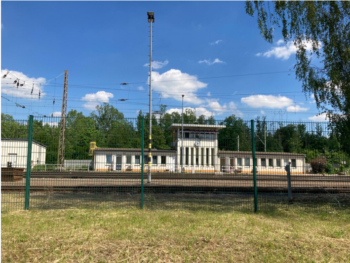
Stellwerk und Relaisraum aus westlicher Richtung Fotograf/Urheber: Nils Schinker
