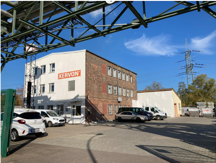
Waschkaue aus südwestlicher Richtung Fotograf/Urheber: Nils Schinker
