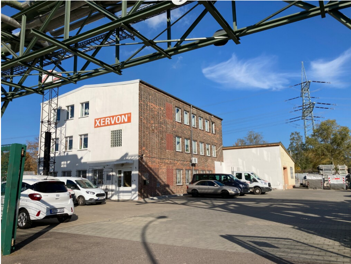
Waschkaue aus südwestlicher Richtung Fotograf/Urheber: Nils Schinker
