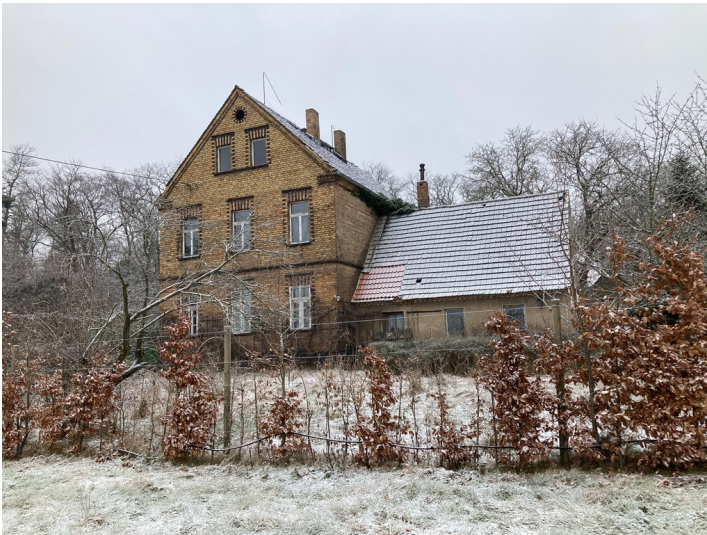
Huthaus und später angebautes Backsteingebäude mit Blick Richtung Norden Fotograf/Urheber: Isabell Schmock-Wieczorek
