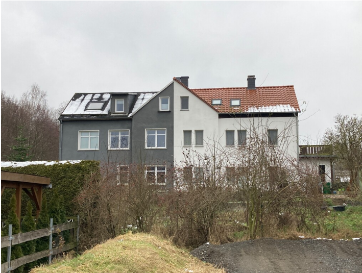
stark überformtes Schachtgebäude der Grube Else aus nördlicher Richtung Fotograf/Urheber: Isabell Schmock-Wieczorek
