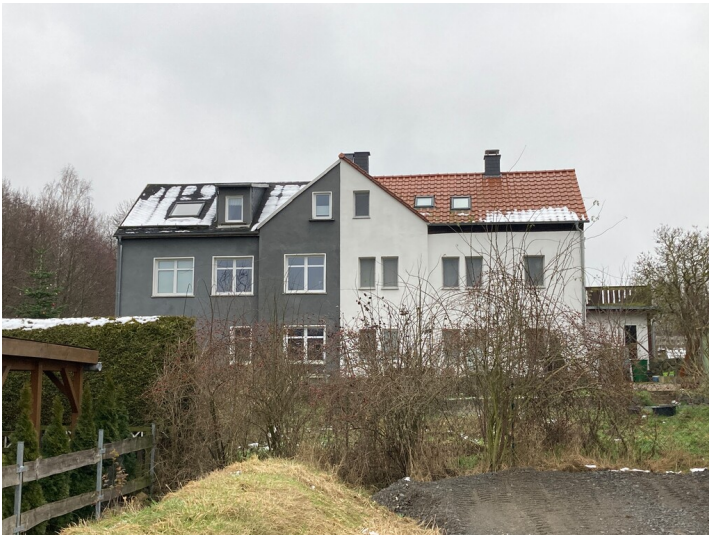
stark überformtes Schachtgebäude der Grube Else aus nördlicher Richtung Fotograf/Urheber: Isabell Schmock-Wieczorek
