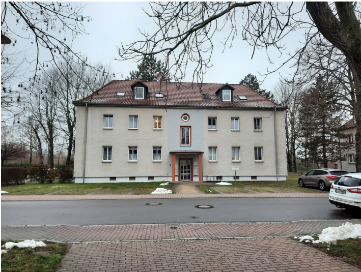
Mehrfamilienhaus an der Ernst-Thälmann-Straße, Blick Richtung Westen Fotograf/Urheber: Isabell Schmock-Wieczorek
