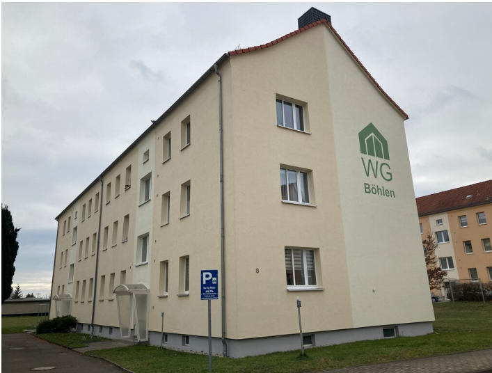
Mehrfamilienwohnhaus an der Emil-Jahn-Straße Fotograf/Urheber: Isabell Schmock-Wieczorek
