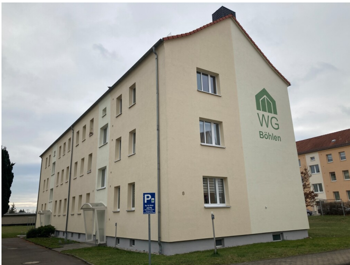
Mehrfamilienwohnhaus an der Emil-Jahn-Straße Fotograf/Urheber: Isabell Schmock-Wieczorek
