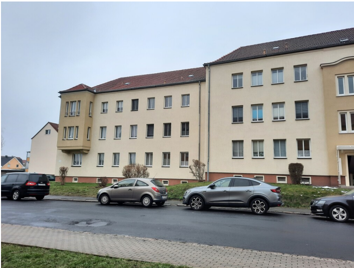
Eckhaus mit Erker aus nordwestlicher Richtung Fotograf/Urheber: Isabell Schmock-Wieczorek
