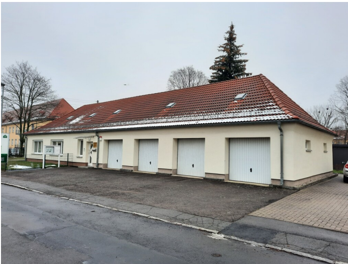
Lager- und Garagengebäude mit Blick nach Nordost Fotograf/Urheber: Isabell Schmock-Wieczorek
