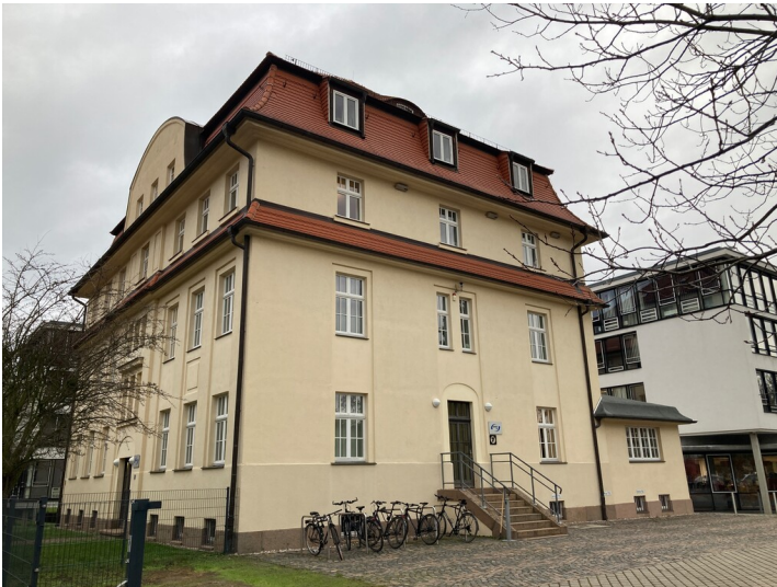
Beamtenwohnhaus mit Blick in nordöstliche Richtung Fotograf/Urheber: Isabell Schmock-Wieczorek
