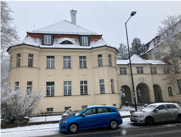
Direktorenvilla aus östlicher Richtung Fotograf/Urheber: Isabell Schmock-Wieczorek
