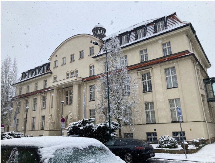
Verwaltungsgebäude aus nordwestlicher Richtung Fotograf/Urheber: Isabell Schmock-Wieczorek
