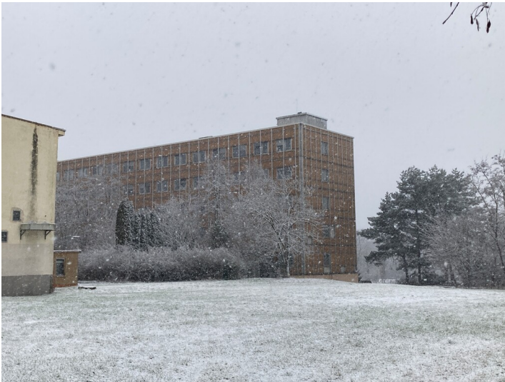
aus nordöstlicher Richtung von der Koburger Straße Fotograf/Urheber: Isabell Schmock-Wieczorek
