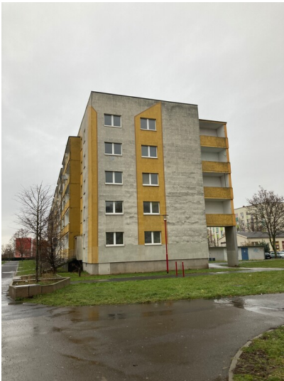
Wohnblock mit zehn Aufgängen, Rudolf-Breitscheid-Straße 41-59, südliche Giebelseite Fotograf/Urheber: Isabell Schmock-Wieczorek
