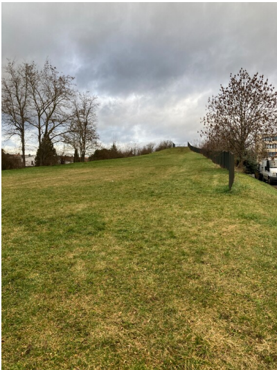
Aufschüttung mit Blick nach Norden Fotograf/Urheber: Isabell Schmock-Wieczorek
