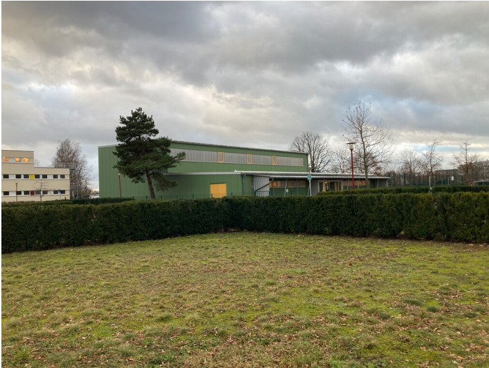
Sporthalle aus nordöstlicher Richtung Fotograf/Urheber: Isabell Schmock-Wieczorek
