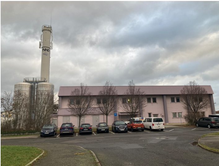
Übergabe- und Umformerstation aus westlicher Richtung Fotograf/Urheber: Isabell Schmock-Wieczorek
