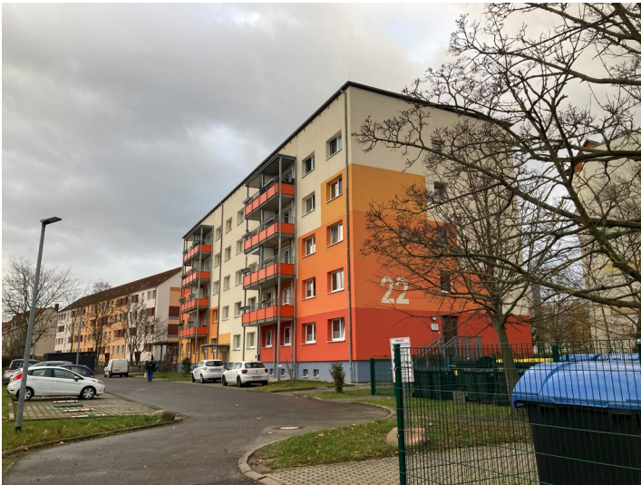
Ledigenwohnheim aus nordöstlicher Richtung Fotograf/Urheber: Isabell Schmock-Wieczorek
