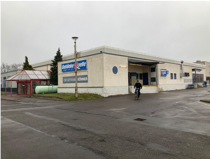
ehemalige Gaststätte mit Blick nach Nordwest Fotograf/Urheber: Isabell Schmock-Wieczorek
