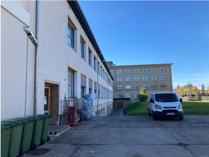
Sozialgebäude aus südöstlicher Richtung Fotograf/Urheber: Isabell Schmock-Wieczorek
