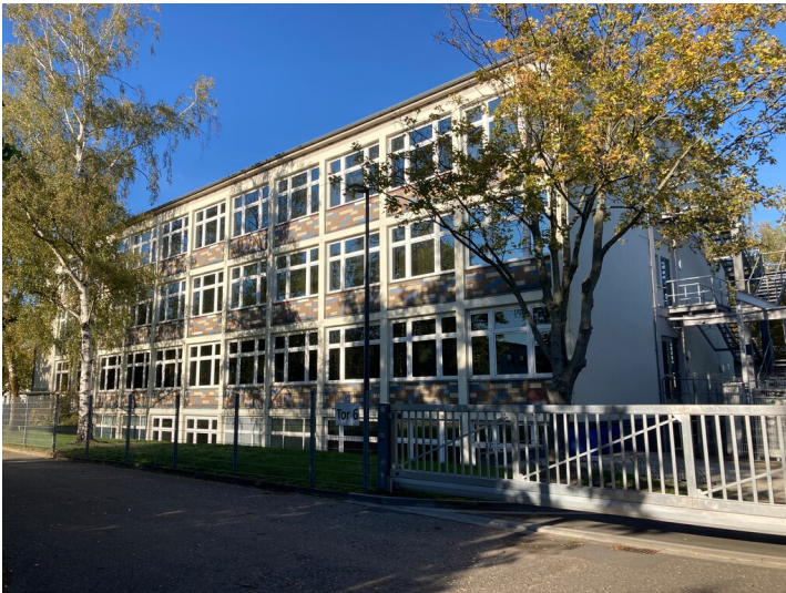
ehemaliges Laborgebäude aus südwestlicher Richtung Fotograf/Urheber: Isabell Schmock-Wieczorek
