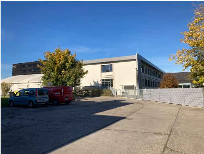
ehemaliges Bürogebäude für Rechentechnik aus westlicher Richtung Fotograf/Urheber: Isabell Schmock-Wieczorek
