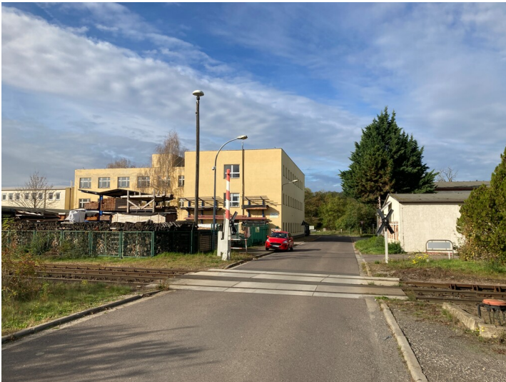
Zimmereigebäude aus östlicher Richtung Fotograf/Urheber: Nils Schinker
