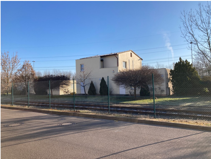
Kopfbau Rangierzentrale aus südöstlicher Richtung Fotograf/Urheber: Isabell Schmock-Wieczorek
