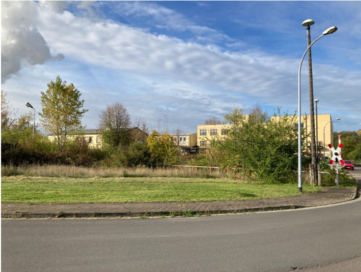
Werkstätten für Hebezeuge aus östlicher Richtung Fotograf/Urheber: Nils Schinker
