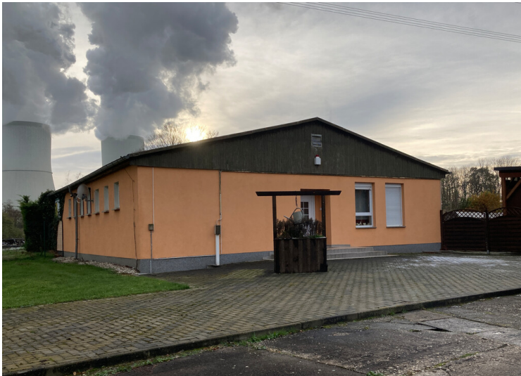
Sozialgebäude mit Blick Richtung Südwesten Fotograf/Urheber: Isabell Schmock-Wieczorek
