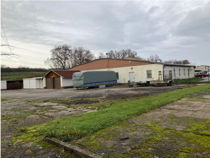
südliche Werkhalle mit Blick Richtung Nordwest Fotograf/Urheber: Isabell Schmock-Wieczorek
