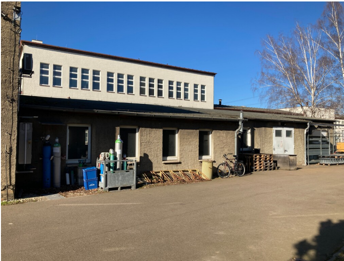
Werkstatt und Lager aus südlicher Richtung Fotograf/Urheber: Isabell Schmock-Wieczorek
