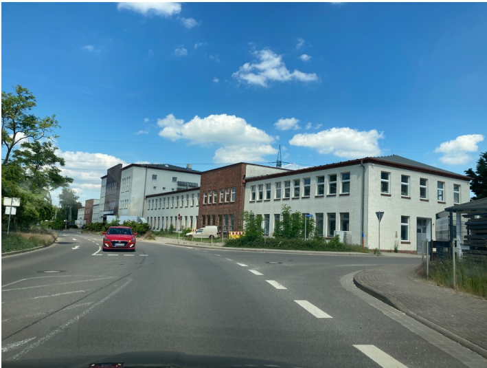
Lehrwerk aus südwestlicher Richtung Fotograf/Urheber: Nils Schinker
