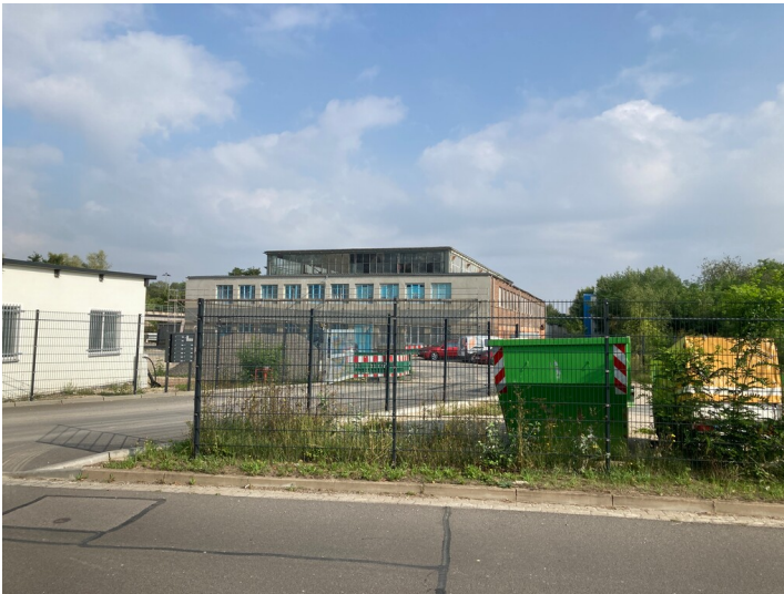
Hauptwerkstatt aus südlicher Richtung Fotograf/Urheber: Nils Schinker
