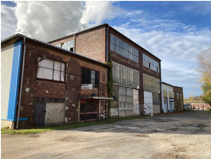
Hauptwerkstatt mit Blick Richtung Südwesten Fotograf/Urheber: Nils Schinker
