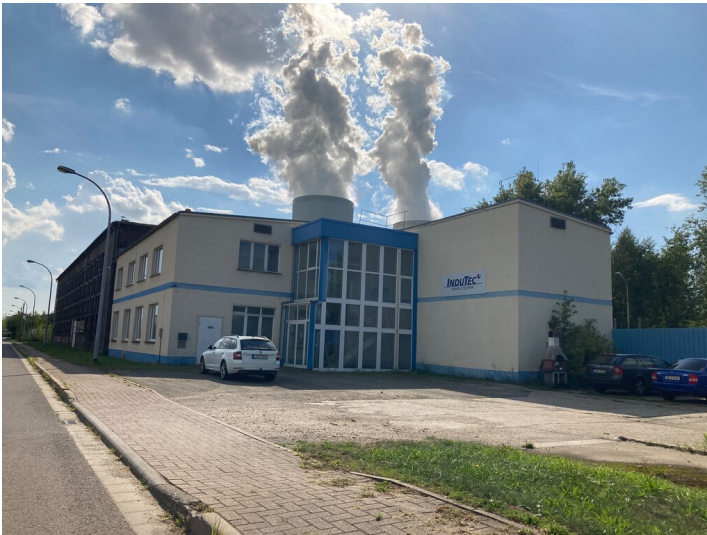
Werkstattgebäude AEK, Lokbau mit Blick Richtung Süden Fotograf/Urheber: Nils Schinker
